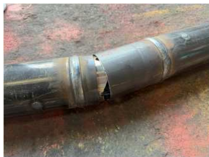
図-6. 曲げ試験後 試験体状況
