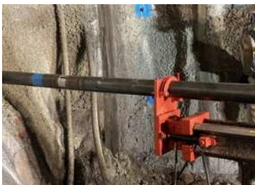
図-2. 現場試験施工状況
